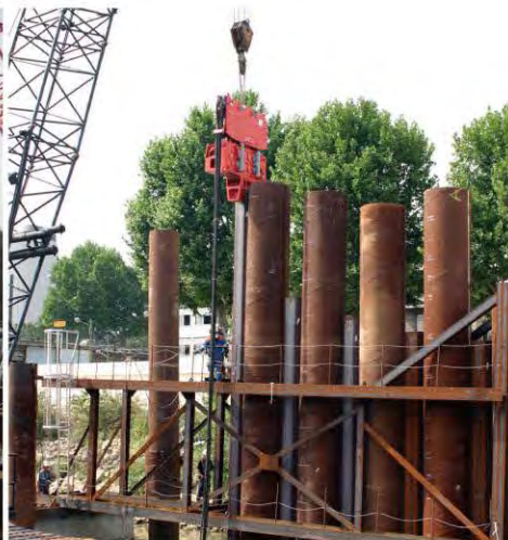
鋼管矢板連続壁
