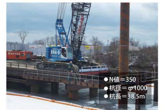
北海道 日高町清島改良工事 超硬質地盤打設状況
