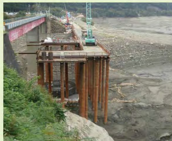
滋賀県 永源寺ダム工事
