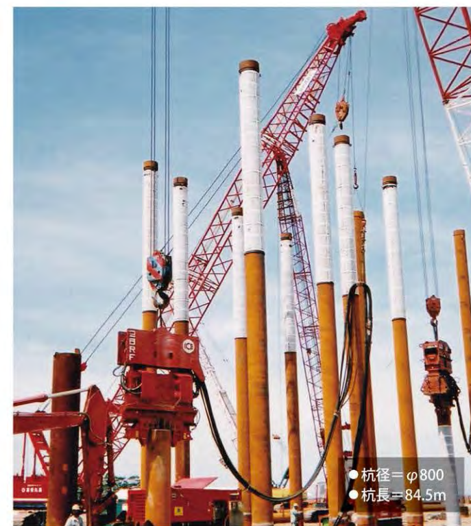
大分県 南日本造船大工場新設工事 最長84m鋼管杭打設状況
