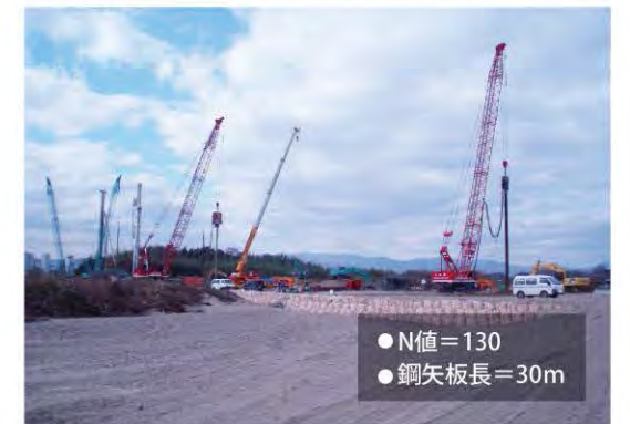
京都府 新名神高速道路 木津川橋(下部工)工事 鋼矢板打設締切状況
