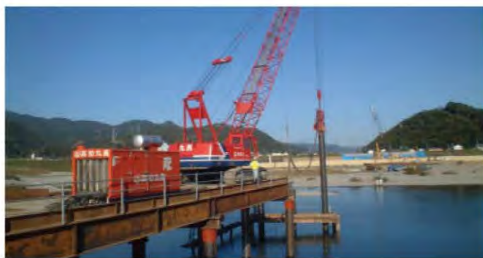
鋼管栈橋SqCピア工法
