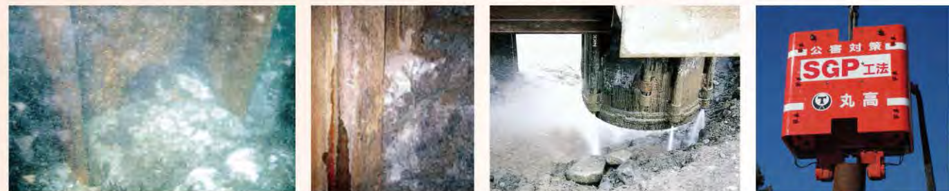
水中テトラロボット貫入状況(写真①) 鋼矢板 硬岩貫入状況(写真②) 先行杭(写真③) 杭打機本体(写真④)
