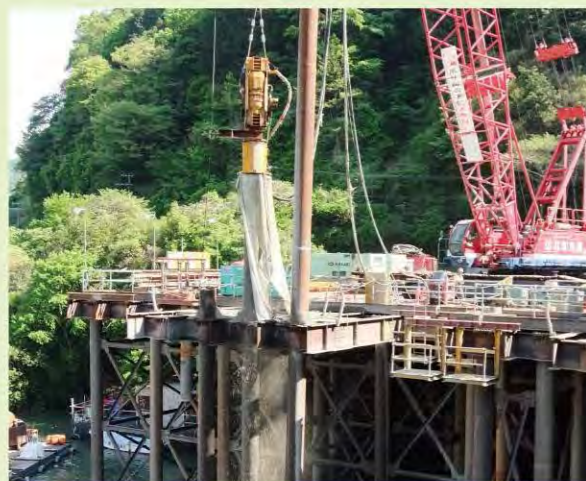
京都府 天ヶ瀬ダム工事
