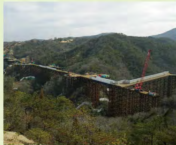
兵庫県 新名神高速道路 坊川第三橋工事
