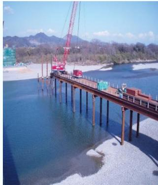
仮栈橋の工費削減・工期短縮が最優先の場合、幅員6.0m以下でクローラークレーンは100t吊以下。この条件に最適な工法がキャップ式SqCピア工法。現場のニーズに柔軟に対応するため長支間に対応。**ロングスパンSqCピア工法**として、支間長15m以内の仮栈橋を、1本物の主桁・横断1列支持杭で可能とします。
