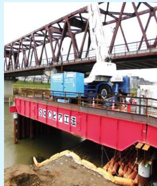
現場の条件により杭打設箇所が限定され支間長を伸ばす必要がある場合、必然的に現場継手を要する主桁が必要となります。**長尺橋梁**は腹板継手にピン連結を採用することでボルト本数を大幅に減らし、超大スパン支間長の栈橋構造の中でも特にシンプルで最も工期・工費の削減につながると思われ、特に緊急性を要する仮栈橋・構台の構造としては最適です。
