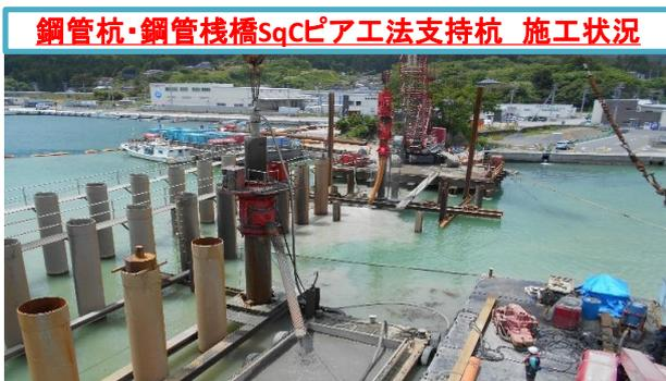
鋼管杭・鋼管棧橋SqCピア工法支持杭 施工状況
