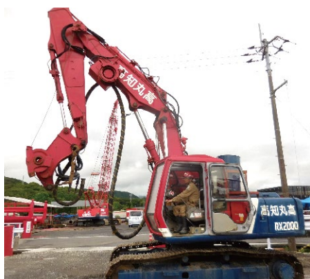
杭打機本体 (RX2000 施工機掘進機30PS)
