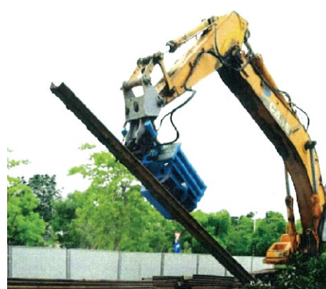
バックホウ0.7㎡ 横チャッキングバイプロ 鋼矢板打込
