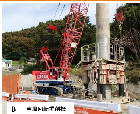
A ロックオーガー掘削機
