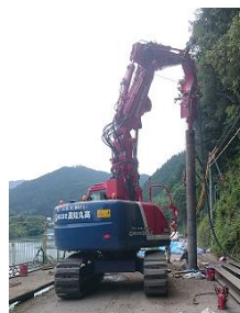
⑥試運転～施工
