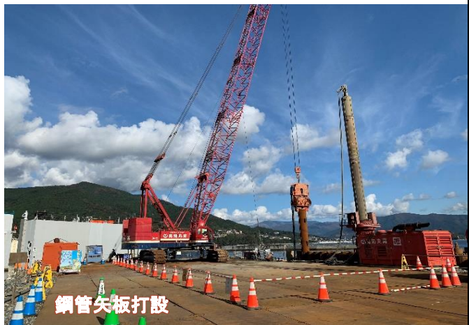
鋼管杭打設(水門)、仮棧橋設置
