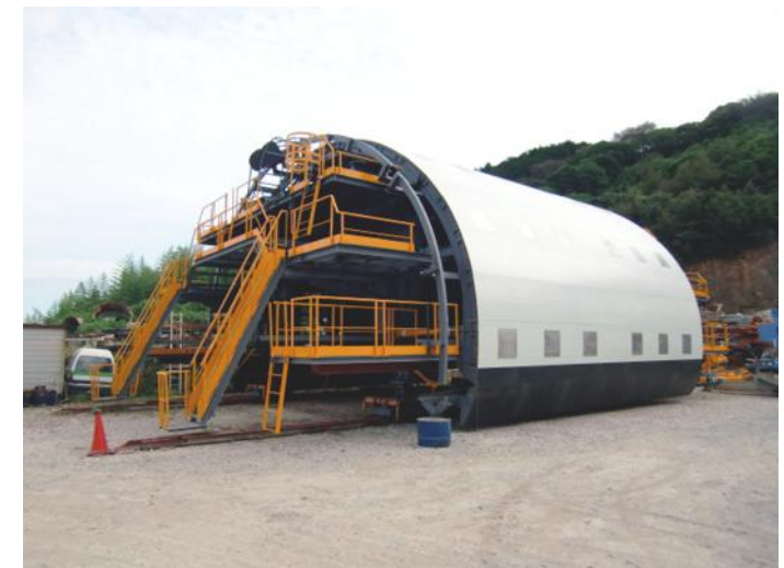
工事名：安上岩出（西側）トンネル工事 発注者：国土交通省近畿地方整備局 和歌山河川国道事務所 様
