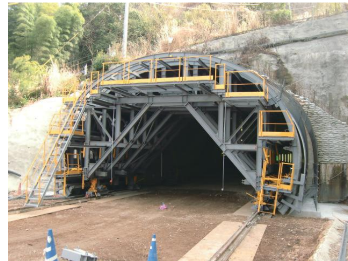
工事名：五台山トンネル（上り線）工事 発注者：高知土木事務所 様
