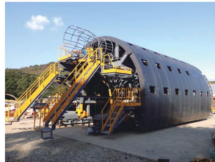
工事名：県道安田東洋線 安全交付金 発注者：高知県安芸土木事務所 様
