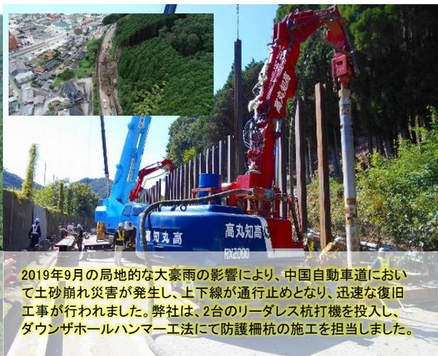
2019年9月の局地的な大豪雨の影響により、中国自動車道において土砂崩れ災害が発生し、上下線が通行止めとなり、迅速な復旧工事が行われました。弊社は、2台のリーダレス杭打機を投入し、ダウンザホールハンマー工法にて防護柵杭の施工を担当しました。
