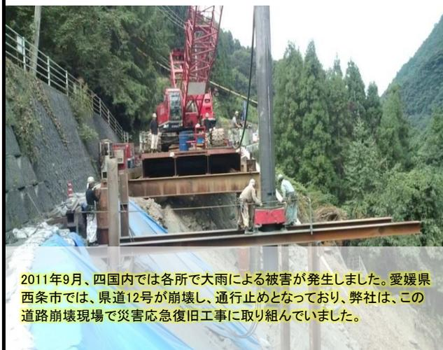
2011年9月、四国内では各所で大雨による被害が発生しました。愛媛県西条市では、県道12号が崩壊し、通行止めとなっており、弊社は、この道路崩壊現場で災害応急復旧工事に取り組んでいました。
