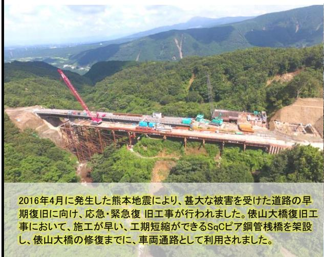
2016年4月に発生した熊本地震により、甚大な被害を受けた道路の早期復旧に向け、応急・緊急復旧工事が行われました。俵山大橋復旧工事において、施工が早い、工期短縮ができるSqCピア鋼管棧橋を架設し、俵山大橋の修復までに、車両通路として利用されました。
