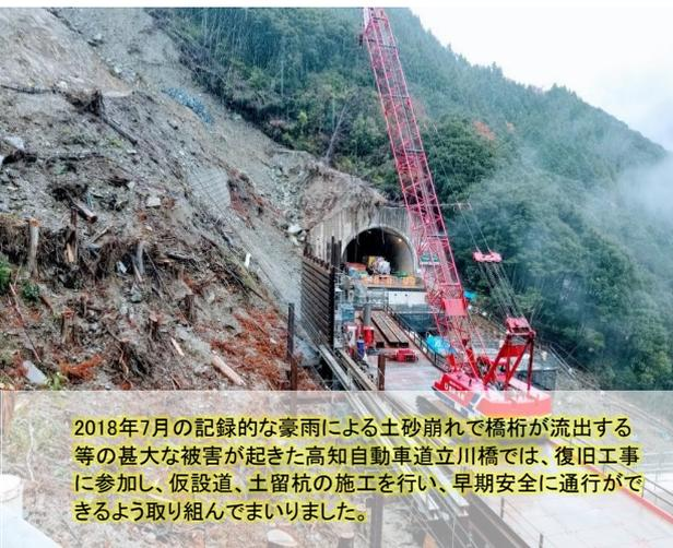
2018年7月の記録的な豪雨による土砂崩れで橋桁が流出する等の甚大な被害が起きた高知自動車道立川橋では、復旧工事に参加し、仮設道、土留杭の施工を行い、早期安全に通行ができるよう取り組んでまいりました。
