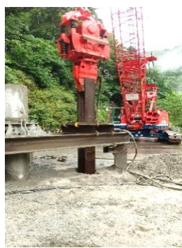
⑧ヤットコ杭打設
