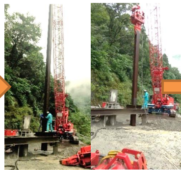
⑥H鋼建込・打設
