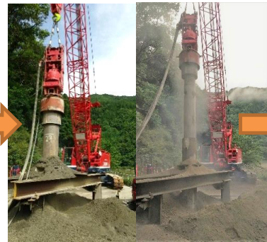
⑥H鋼建込・打設
