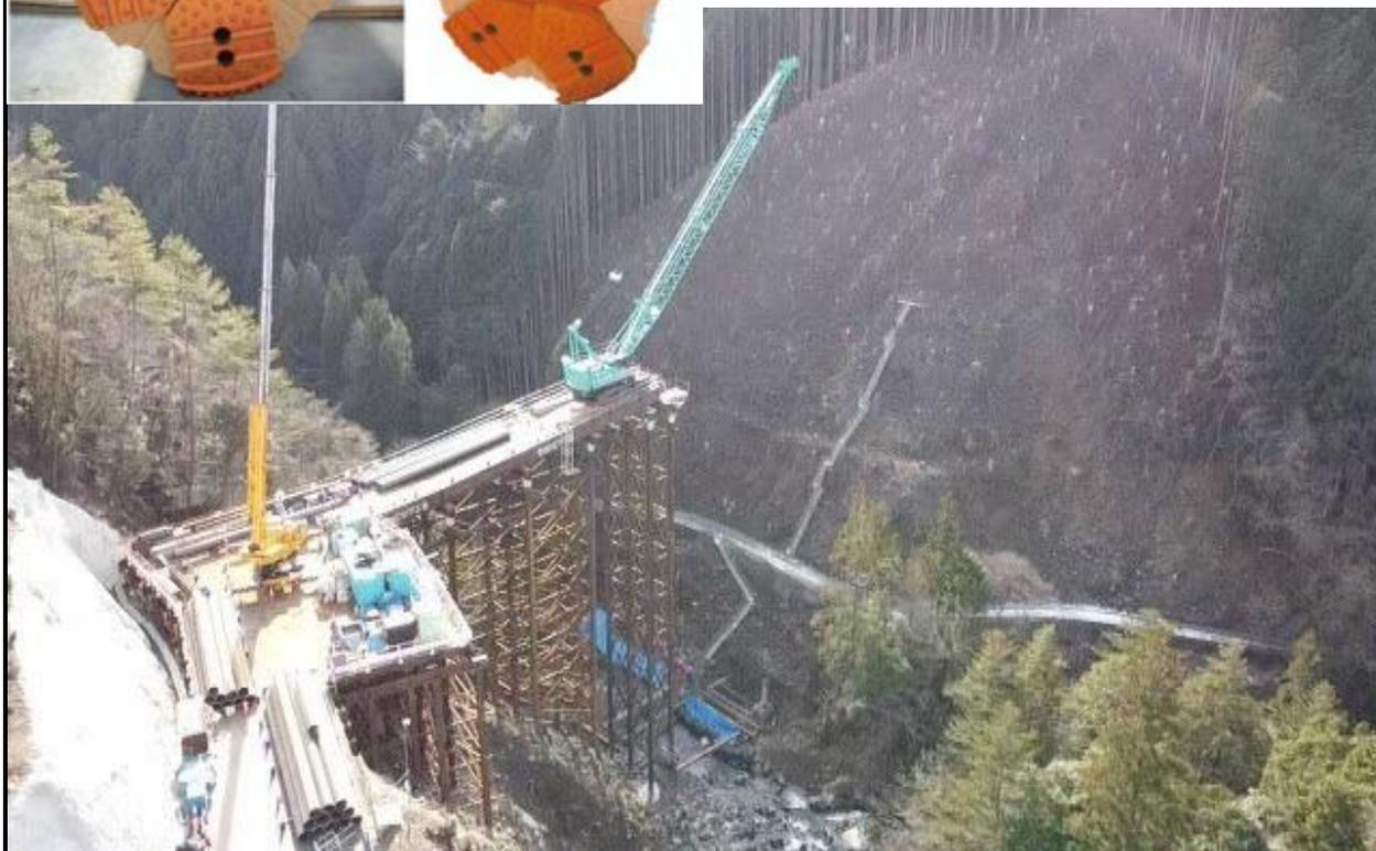
東海地方にあるダム現場では、河川の際で施工を行っており、天然記念物のネコギギがいるため、自然環境に配慮しながら、**鋼管桁橋SqCピア工事**を進める必要があり、超低振動・超低騒音のARハンマ工法が採用されました。
