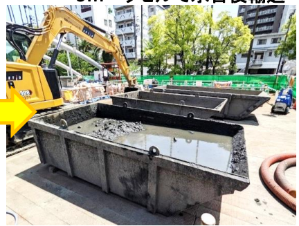
⑥土砂仮置 3m 3 ベッセルで水替後輸送
