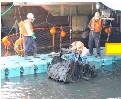
④ドラグラインバケットで掘削
