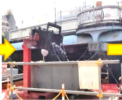
⑤掘削土をベッセルに積込
