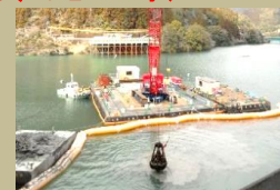
四国地方 (ユニフロート組立式台船 しゅんせつ工事)
