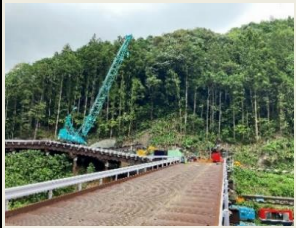
四国地方 (鋼管棧橋SqCピア キャップ工法)
