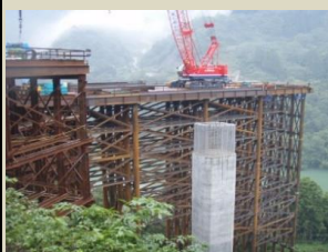
北陸地方 (鋼管棧橋SqCピア 上部パネル先行架設工法)
