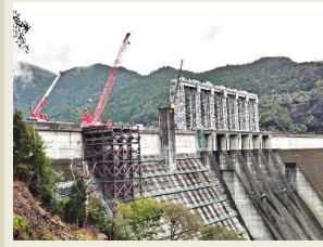
四国地方 (仮橋工事施工中)
