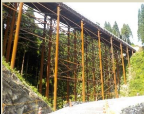
近畿地方 (鋼管棧橋SqCピア キャップ工法)
