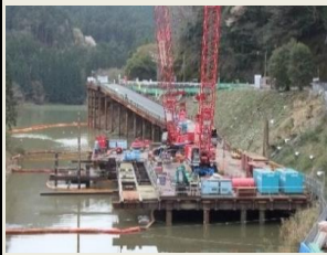
九州地方 (鋼管棧橋SqCピア 上部パネル先行架設工法+キャップ工法)
