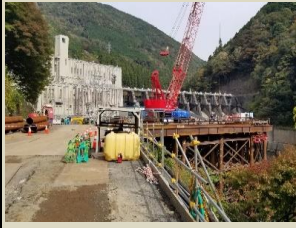
中部地方 (鋼管棧橋SqCピア 上部パネル先行架設工法)
