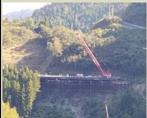
中国地方 (鋼管棧橋SqCピア キャップ工法)
