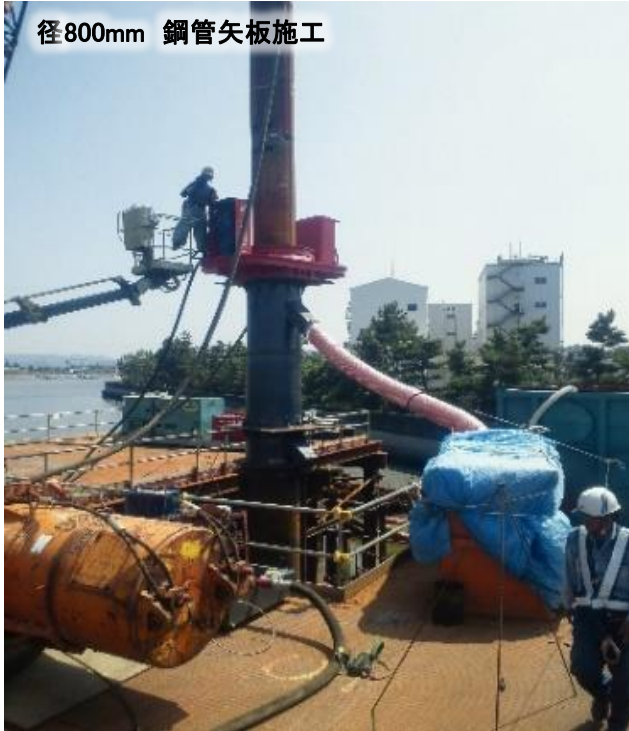
径600mm SqC π 用鋼管支持杭施工
