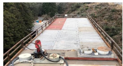
⑩ 手摺り設置
