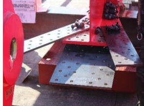
② プレート設置
