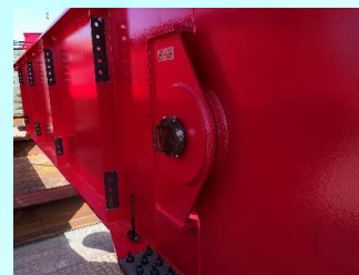
ピン連結構造
