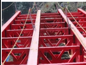
⑧ 対傾構架設
