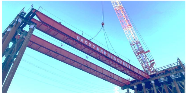
⑦ 主桁架設
