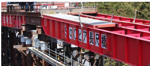
⑨ 覆工板敷設
