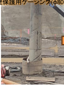
拡径式DHハンマーによる先行削孔
