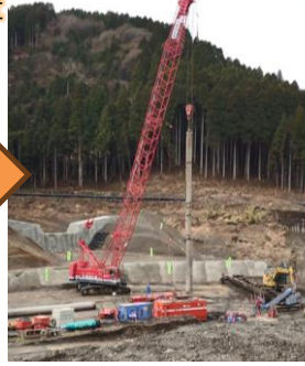
拡径式DHハンマーによる先行削孔
