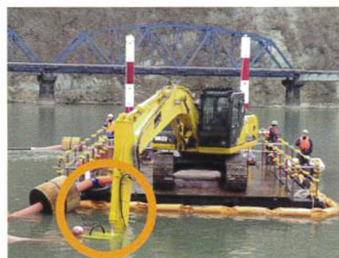
水深0～10m 台船上バックホウ取付例
